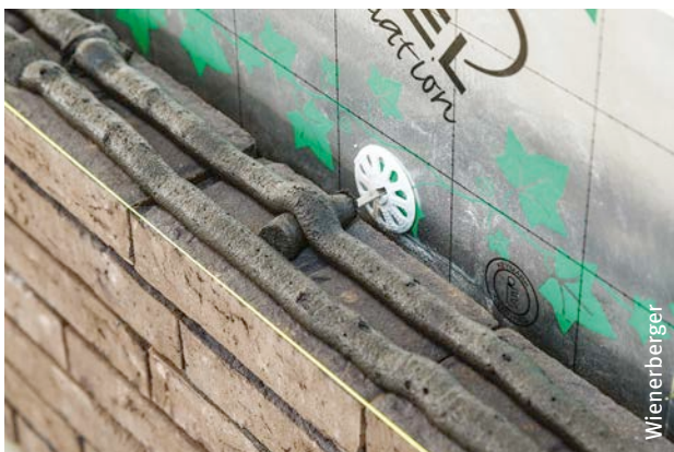
Afb. 67 Inwerken van een anker in de mortellijm.
