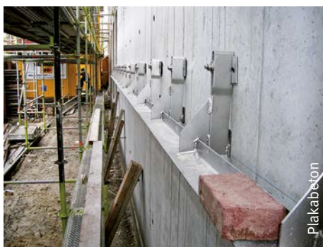
Samengevoegde latei uit geauto-claveerd cellenbeton
