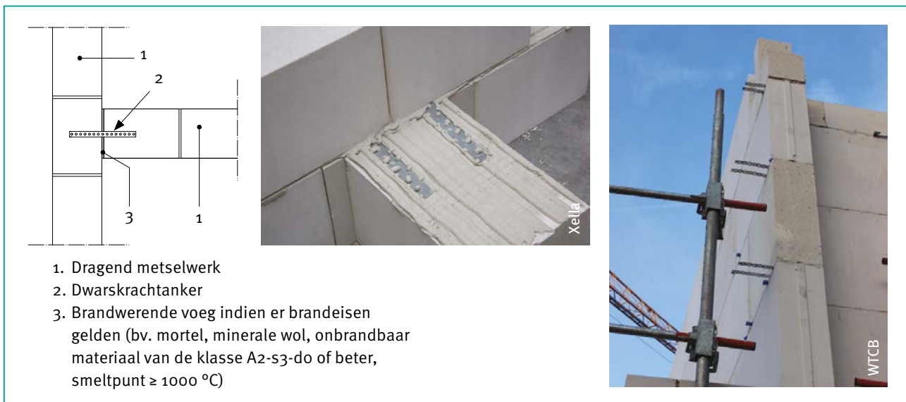
Afb. 81 Voorbeelden van verbindingen met behulp van dwarskrachtankers (koppelstrips).
