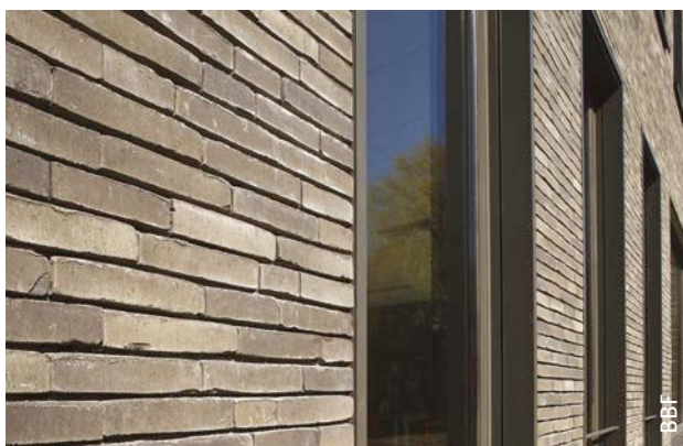
Afb. 46 Gelijmd baksteenmetselwerk met dunne voegen.
