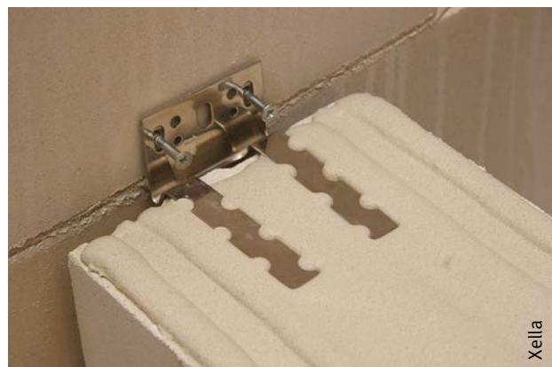
Afb. 82 Voorbeeld van een glijanker (veeranker).
