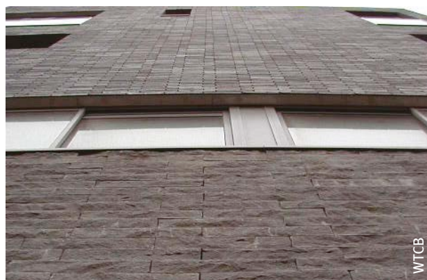
Afb. 47 Gelijmd metselwerk met metselstenen uit natuursteen met dunne voegen.
