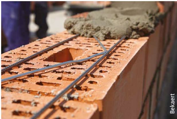
Afb. 66 Lintvoegwapening uit gelaste draden (vakwerktipe).
