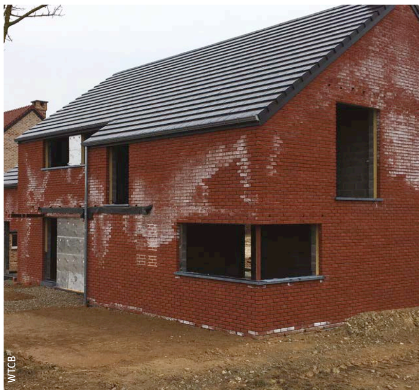
Afb. 61 Verschijning van uitbloeiingen in de lente wanneer de drogingsomstandigheden gunstig zijn.
