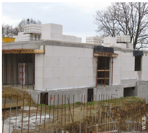
Afb. 38 Metselwerk uit kalkzandsteenblokken met dunne voegen (0,5 - 3 mm).
