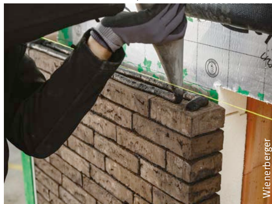
F. Aanbrengen van de mortellijmrillen met behulp van een spuitzak
