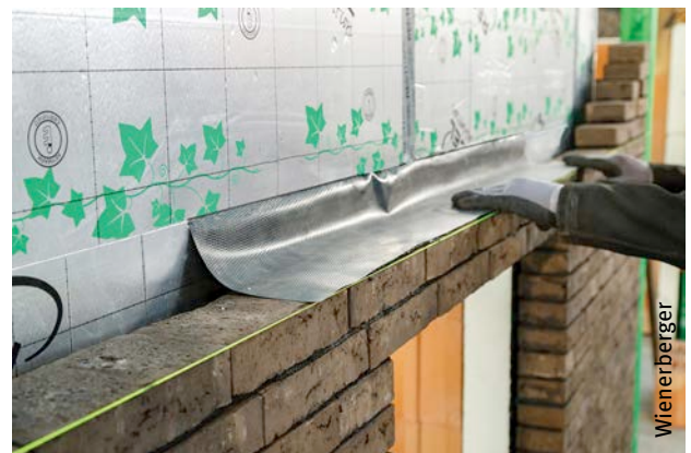
Afb. 93 Draineringsmembraan boven een opening.
