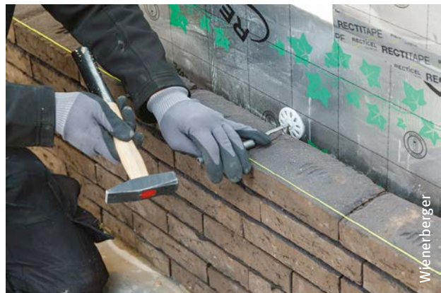
Afb. 68 Mechanische bevestiging van een anker.
