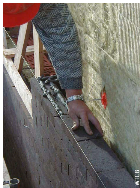
F. Aanbrengen van de mortellijmrillen met behulp van een spuitzak
