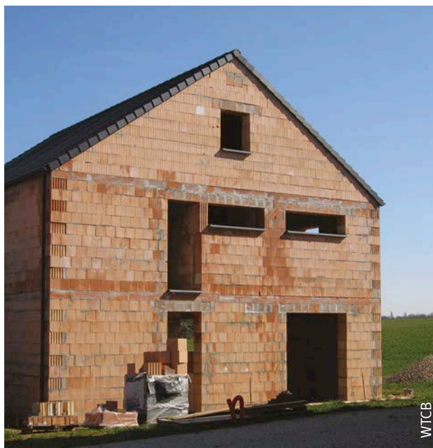
Afb. 11 Dragend metselwerk uit baksteen met dunne voegen (van 0,5 tot 3 mm).
