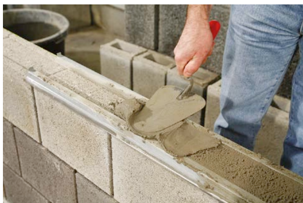
Afb. 7 Metselstenen uit beton die de grip en/of de dosering van de mortel vergemakkelijken.
