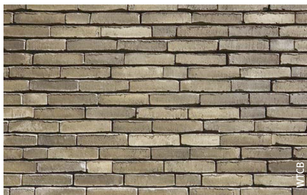
Afb. 41 Gelijmd metselwerk met dunne voegen. Onregelmatige baksteen in wild verband.
