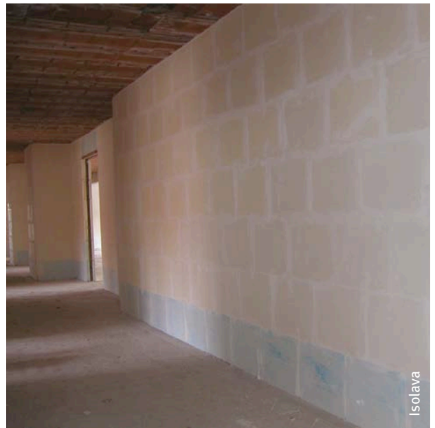
Afb. 59 Niet-dragende binnenwand uit gipsblokken.
