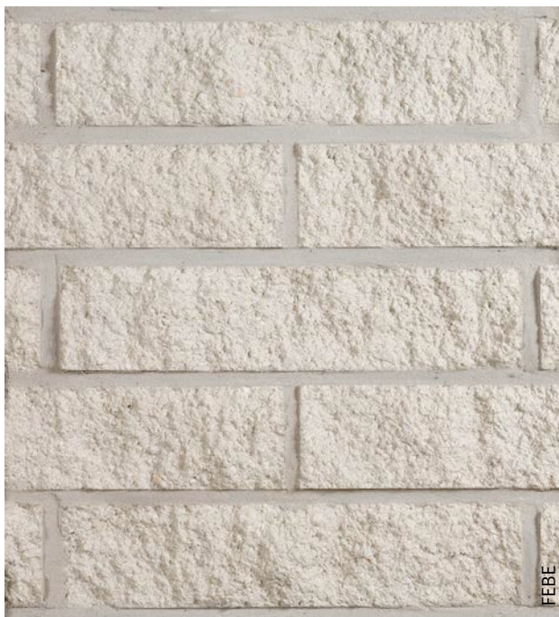
Afb. 18 Gekloofde metselstenen uit granulaatbeton voor gevelmetselwerk.
