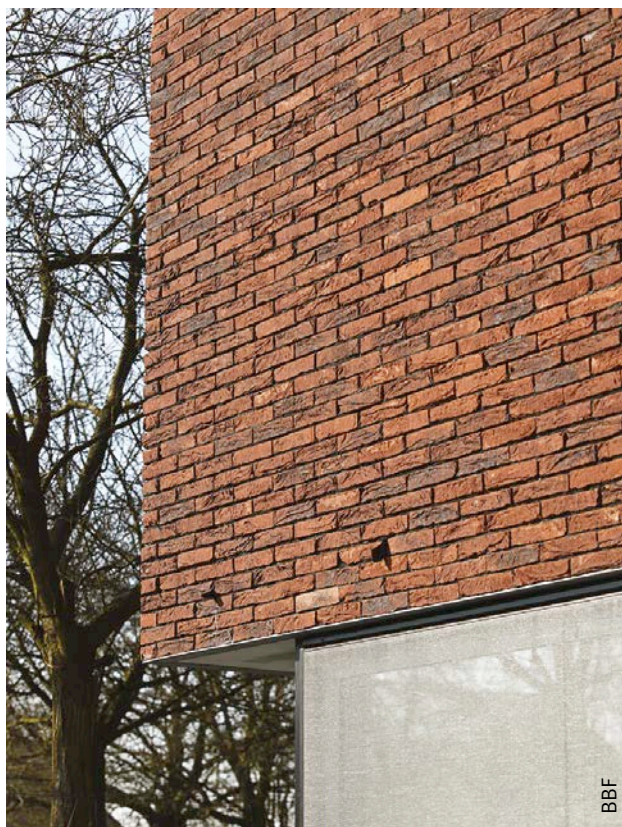
Afb. 1 Gevelmetselwerk uit baksteen, gelijmd met dunne voegen.
