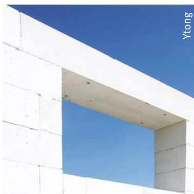
Samengevoegde latei uit geauto-claveerd cellenbeton
