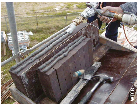
E. Aanbrengen van de mortellijmrillen op de kopse kanten
