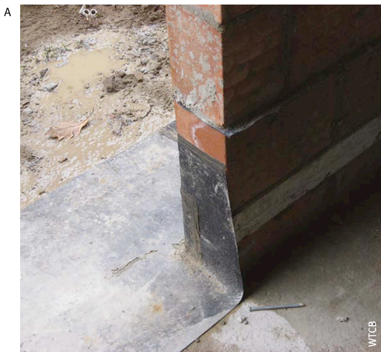
Afb. 88 Muurvoet van het binnenspouwblad.
