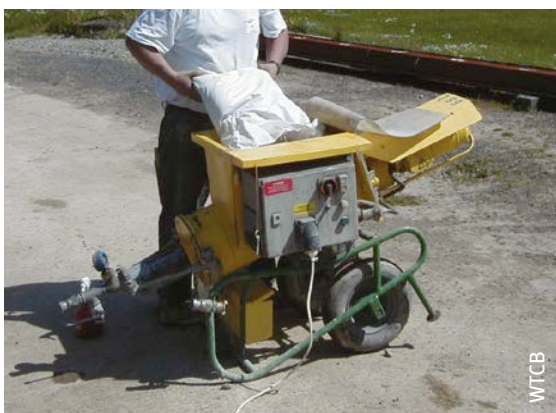
A. Uitstorten van het mortellijmpoeder in de trechter van de pomp
