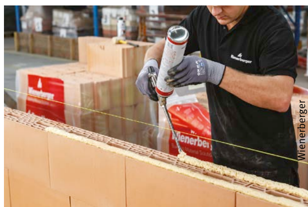
Afb. 8 Verlijming van blokken met behulp van een PU-schuimlijm.
