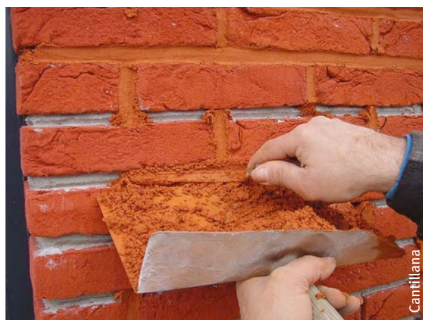
Afb. 113 Navoegen met een gepigmenteerde mortel van een voldoende uitgekrabd metselwerk.
