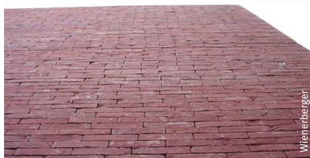
Afb. 39 Gelijmd metselwerk met dunne voegen. Regelmatig verband. Slechte uitlijning van de stootvoegen omwille van een baksteen met minder strenge toleranties.
